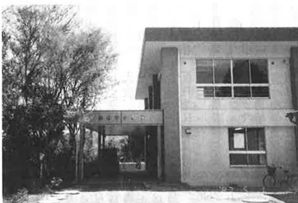
千種川べりの高台に建つ「はなさきむら」
